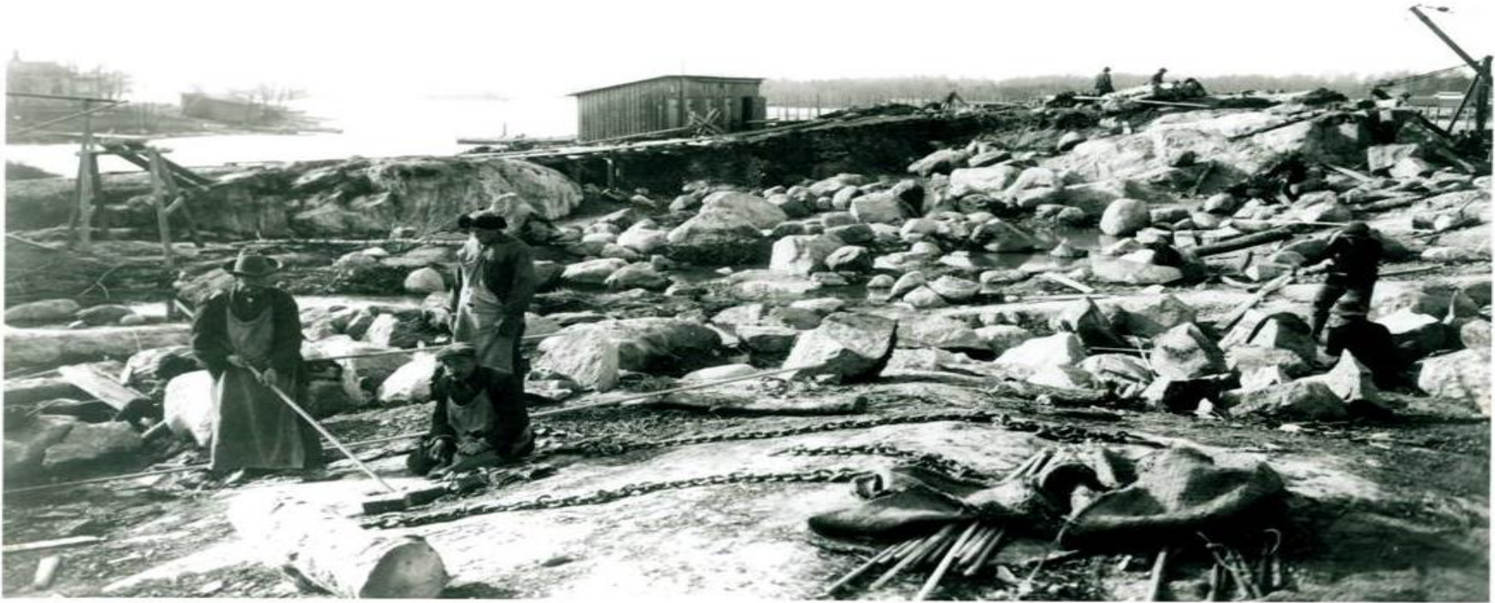
SATAMANRAKENNUSTÖITÄ JÄTKÄSAARESSA valok. Signe Brander 1913
