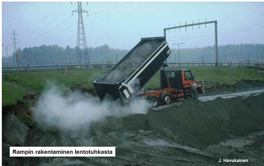
Penkereen rakentaminen lentotuhkalla (80-luvulla)
