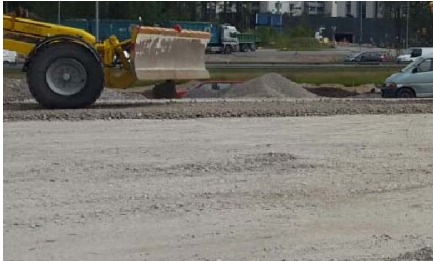
Betonimurskekerroksen levitys ja tiivistys (10-luvulla)
