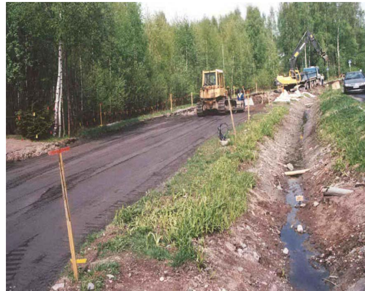
Pohjatuhkakerroksen esitiivistys (00-luvulla)
